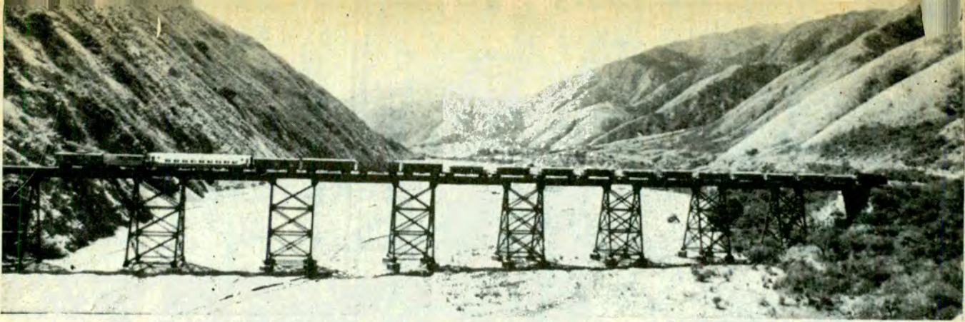
Un tren mixto, compuesto por varios vagones de carga y un vagón de pasajeros, atraviesa el viaducto Toro, en la parte inferior de la quebrada, para dirigirse a Socompa, impulsado por una poderosa locomotora diésel eléctrica.
